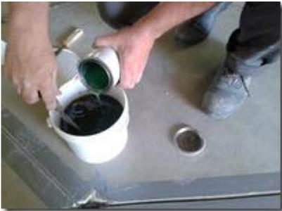
Si nécessaire, doser ou peser la quantité de résine et de durcisseur dont vous avez besoin (voir tableau sur le seau). Verser la résine dans le seau contenant le sable catalyseur, en mélangeant légèrement.
