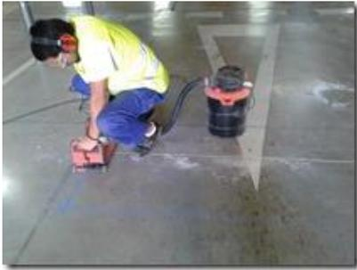
Réaliser le sciage à la dimension de la boucle et chasser l'eau de la saignée
