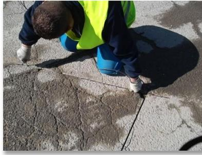
Mettre en place la boucle en la bloquant au fond de la saignée tous les 50 cm
