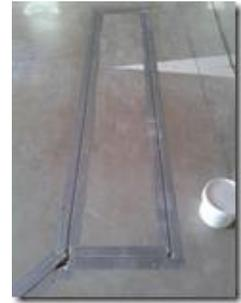
Pour une finition parfaite, protéger les bords du sciage à l'aide d'un ruban adhésif
