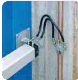
Connexion sur le bloc de dérivation avec raccords à 6 voies
