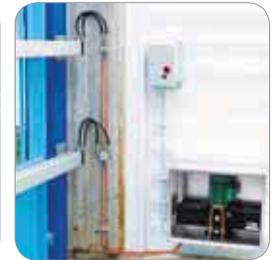
Centrale hydraulique MEC 700/80 VENTIL avec double réservoir dans l'armoire de protection.
